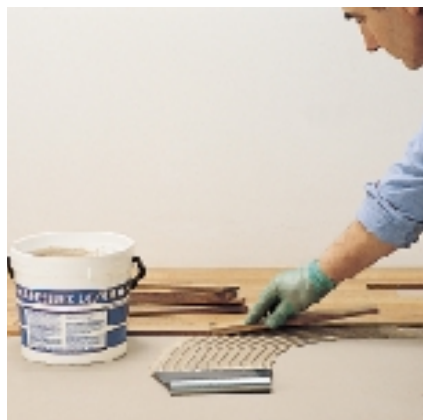
Colocación de listoncillos de MUHUUH
